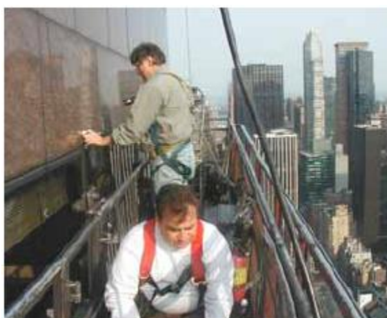
Probando la calidad del anclaje en paneles de granito En edificio de gran altura
