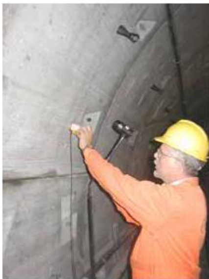
Buscando vacíos detrás de la línea del túnel
