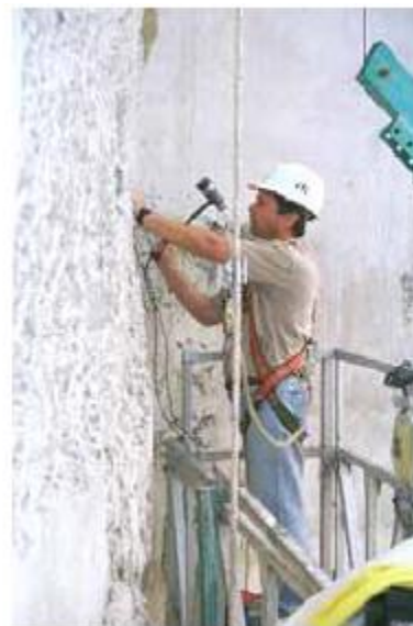
Buscando segregaciones en un silo
